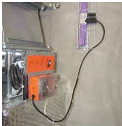
Anschluss der kommunikativen Brandschutzklappenantriebe mit Woertz Flachbandkabel 230V und LON-Bus in einem Kabel.
