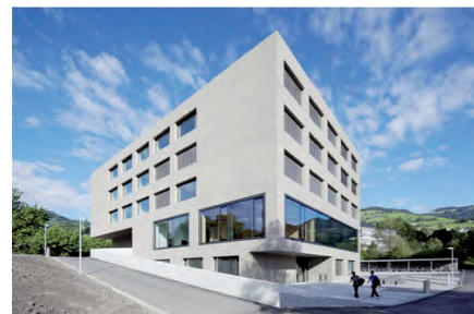
Gebäuderückseite mit Sicht auf die Grossfenster der Aula
